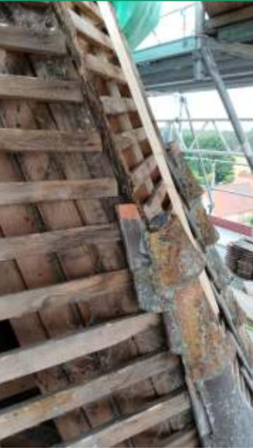
Bild links vom 8. Juli, Bild rechts vom 21. Oktober. Die vermoderte Lattung ist erneuert, die Grate werden eingeleicht und als Trockengrate ausgeführt.
